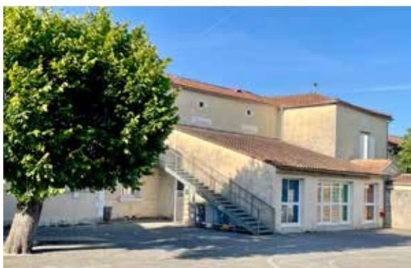
**Changement des menuiseries** à l'école de St-Amant : les anciennes menuiseries n'étant pas isolantes et étant en mauvais état, il est prévu de changer les fenêtres de la cuisine et les portes fenêtres du réfectoire.
